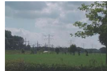
Noordzijde van de kern begrensd door spoorlijn en hoogspanningsleiding.
