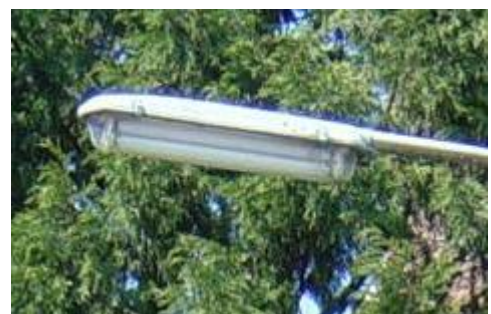
Figuur 6 Verouderd armatuur met TLS20 lampen
